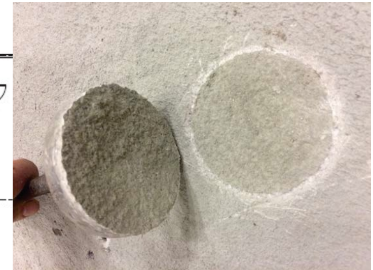
Pente test no 2
